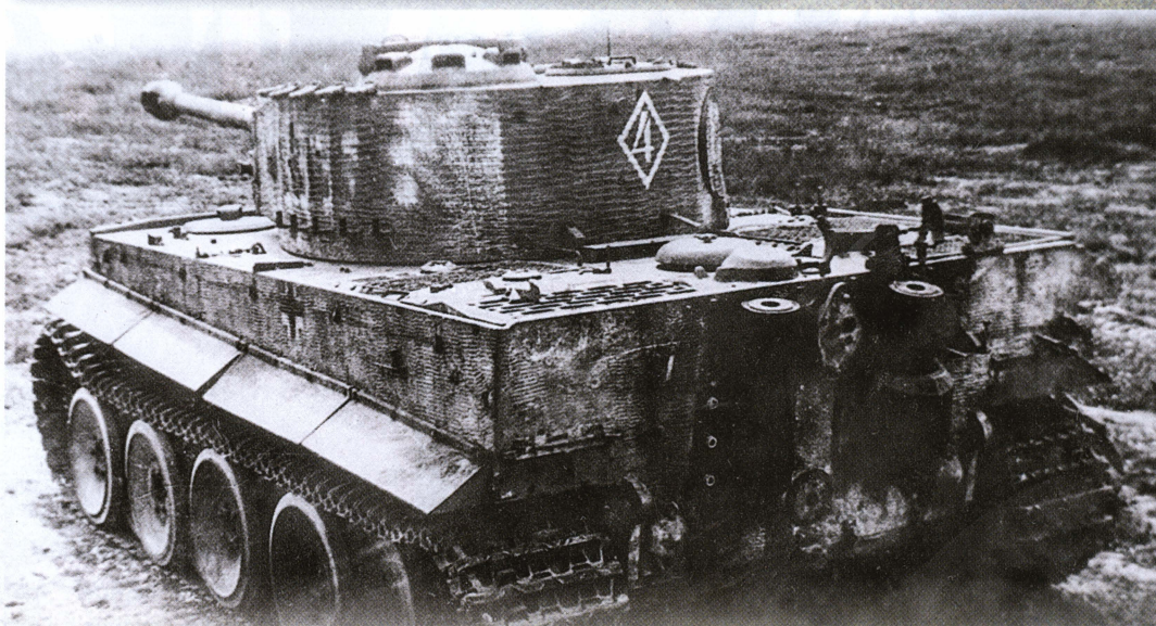
Танк Pz.VI «Тигр», использовавшийся на НИБТ полигоне в подмосковной Кубинке для различных испытаний. На задней части башни видно советское обозначение — белая цифра 4 в ромбе.
